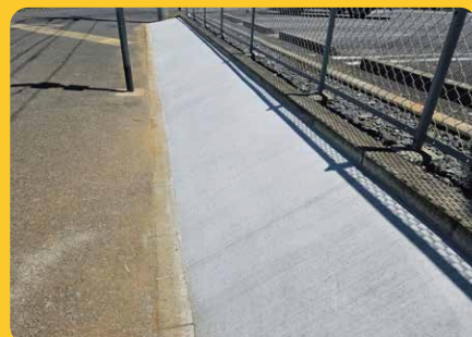
張りコンクリート
